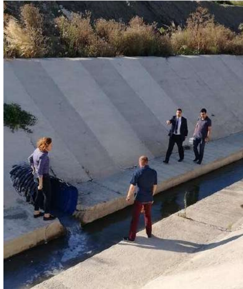
Kavakdere’de görülen anormal akışa ait baca-işletme tespit çalışmaları
